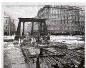
Разрушенный Египетский мост
