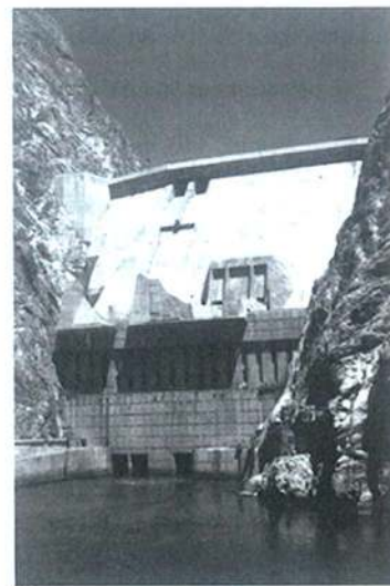
Рис. 110. Плотина Токтогульской ГЭС.
